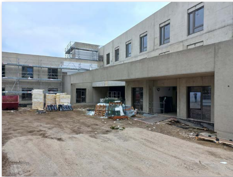
Chantier EHPAD La Sarra- Photo : CCAS de Lyon
